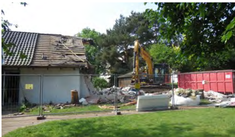
Die Umbauarbeiten für ein Barrierefreies Bauernhaus haben begonnen. Dort, wo der marode Teil des Werkstattgebäudes abgerissen wurde (s.o.), wird bald der Eingang (mit Treppenhaus) für die Wohngruppe Bauernhaus sein.
